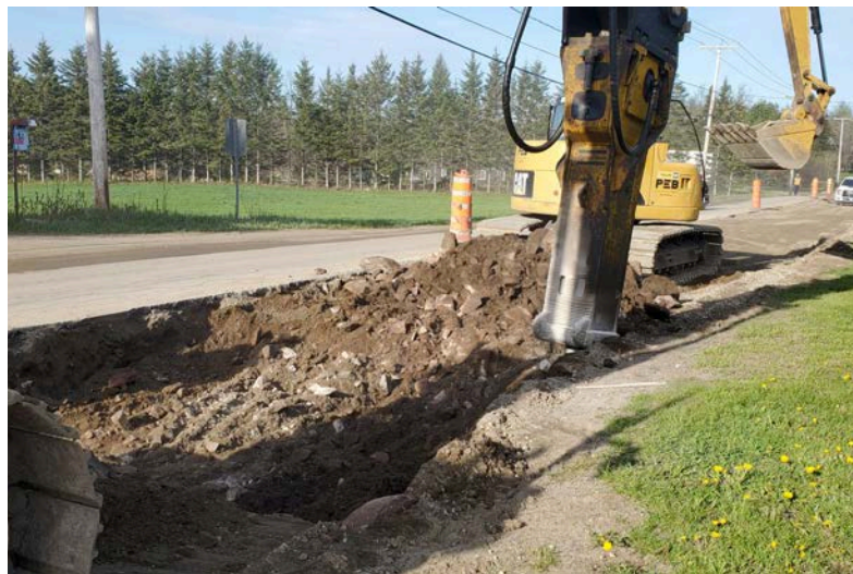
Travaux de voirie routes Montcalm et des Érables
