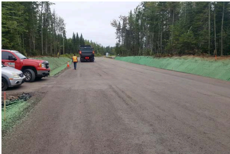
Construction rue entre Edward-Asse et du Levant
