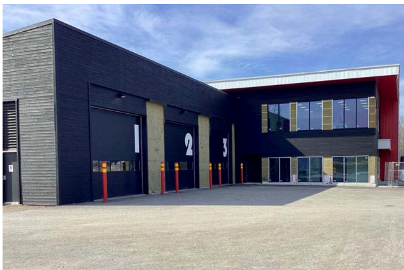
Agrandissement du poste incendie
